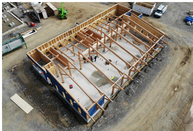
Photographies du chantier
