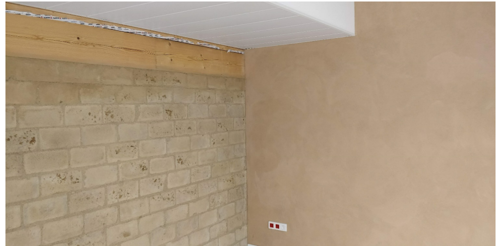
Refends BTC et enduits terre crue
