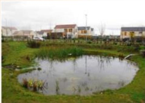
Bassin d'infiltration, lotissement sans réseau pluvial.
