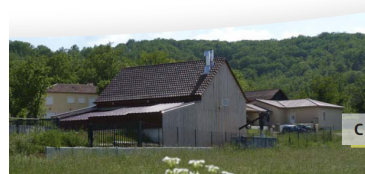
C - Chaufferie bois collective à Saint-Germain-du-Bel-Air (Lot), Architecte : Patrice Bosc © SYVED du Lot.
