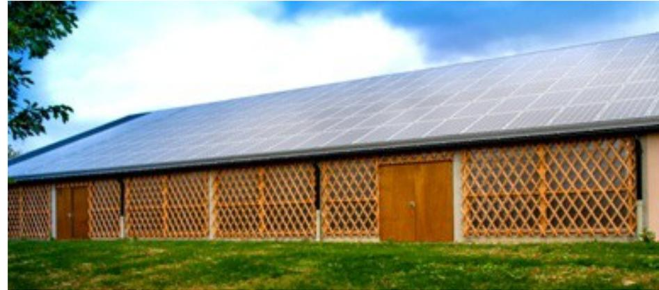
**Travaux** réalisés en 2013 : installation de 240 m<sup>2</sup> de panneaux photovoltaïques (40 kW) sur la toiture du musée des traditions agricoles du Ségala.
