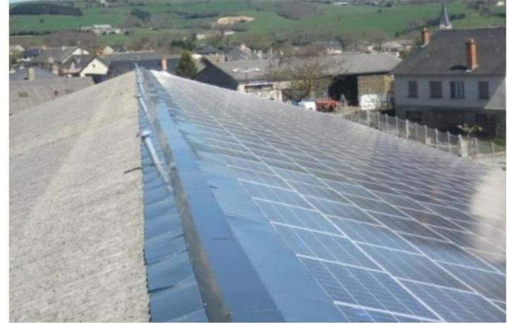
**Travaux** réalisés en 2011 : installation de 900 m<sup>2</sup> de panneaux photovoltaïques (115 kW) sur la toiture du marché couvert communal.
